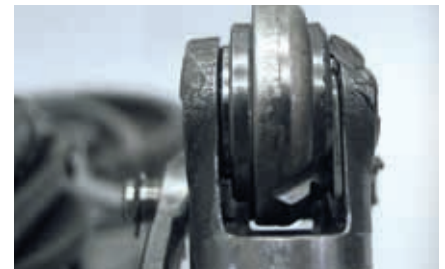
Imaginea deteriorării: rola transportoare tocită pe o parte
