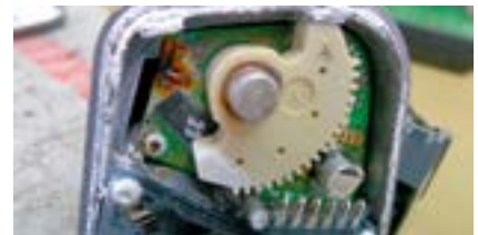
Вид поврежденной регулирующей заслонки изнутри
