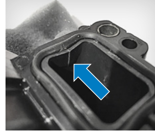
Şek. 2: Kırılma (hasar belirtisi)
