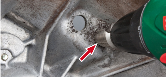
Figur 5: Utboring av hullene
