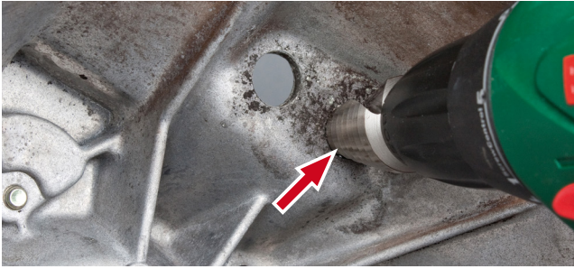
Bild 5: Uppborring av öppningarna
