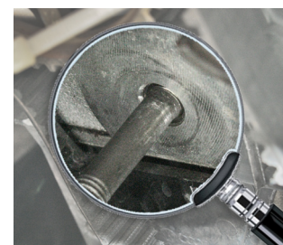
Figur 2: Skruen er skrudd inn riktig
